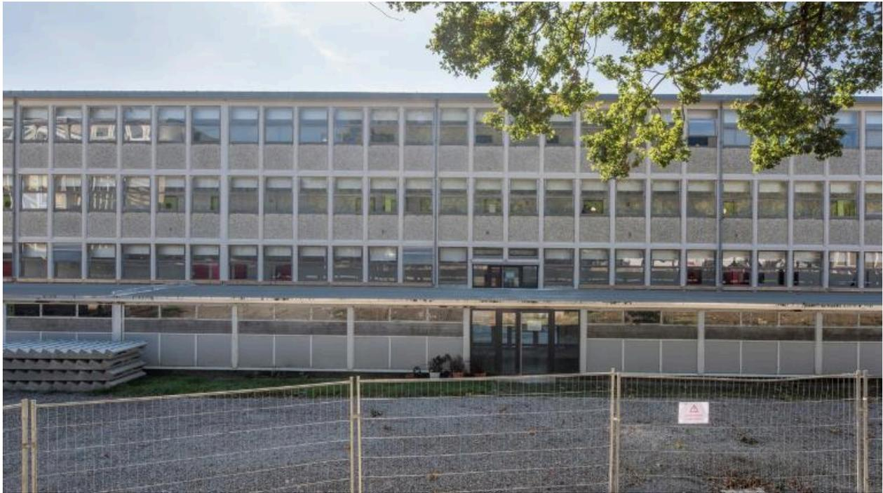
Bâtiment C (externat), détail sur la façade nord. Au premier plan, galerie de circulation hors œuvre ("le métro") ajoutée postérieurement à la construction pour absorber des flux trop denses dans les dégagements du bâtiment.
