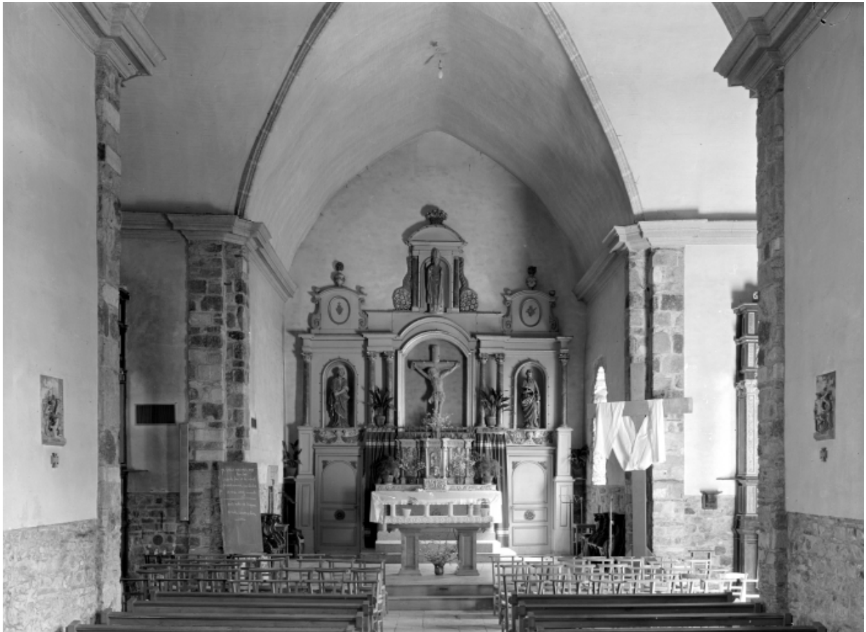
Choeur, vue générale prise de l'ouest.
