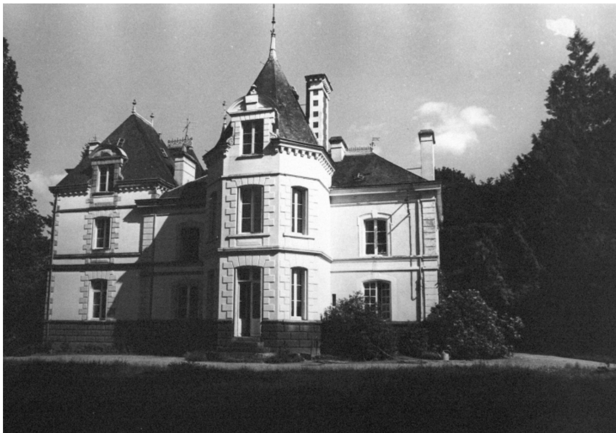
Vue générale nord
