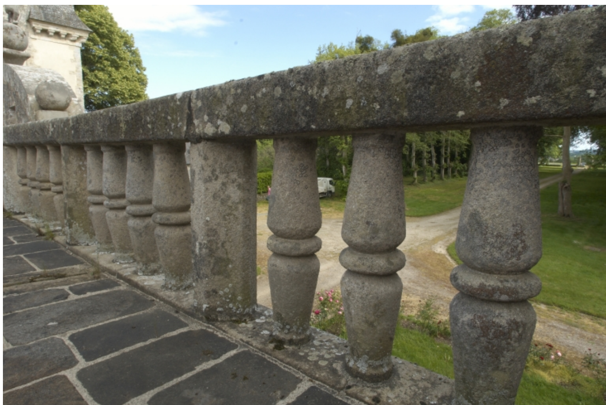
Corps de passage, garde-corps
