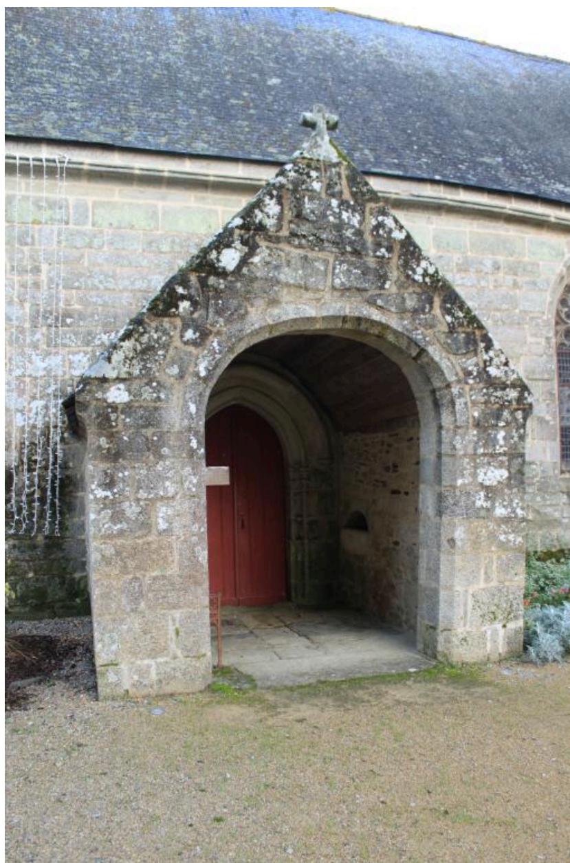
Eglise Saint-Mériadec de Stival, Pontivy, porche sud.
