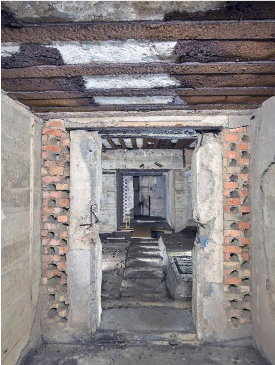
Vue du passage des câbles de la salle des compensateurs au puits d'antenne nord-est via un sas étanche. Ils sont photographiés depuis le sas étanche ; au centre, porte disparue
