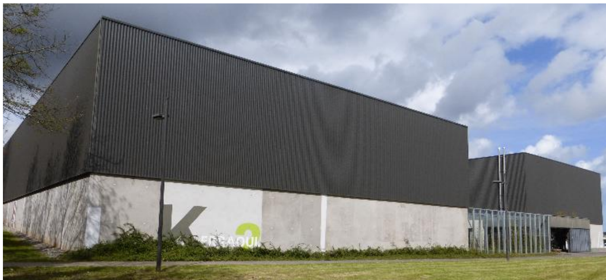
Façades est et pignon sud d'une des salles du gymnase Kerraoul 2 (Paimpol)
