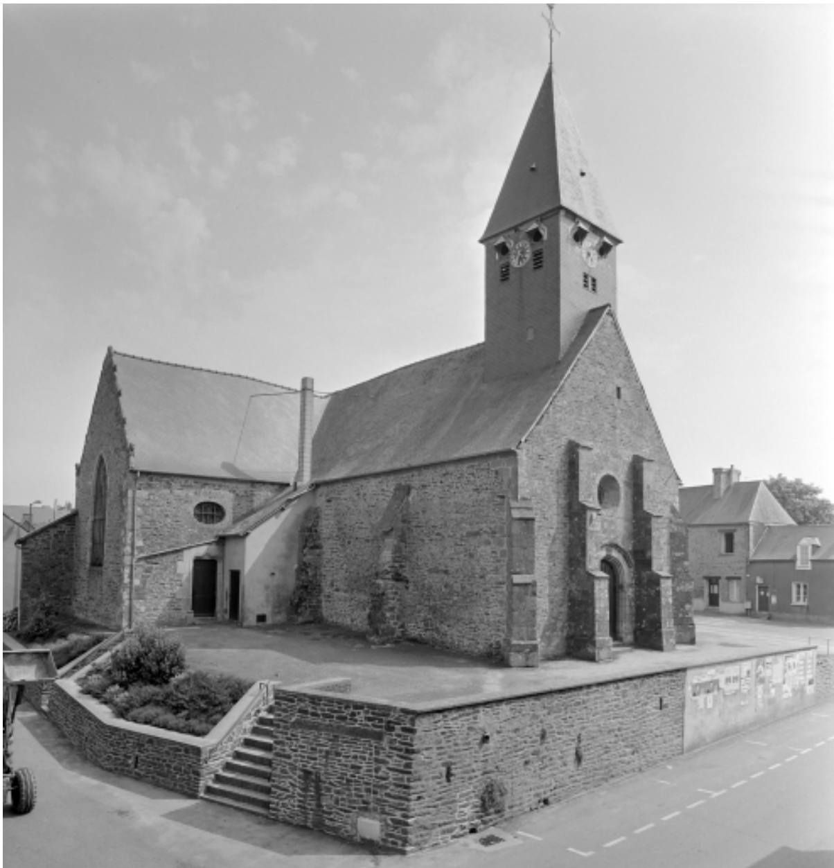
Elévation Nord-Ouest : vue générale
