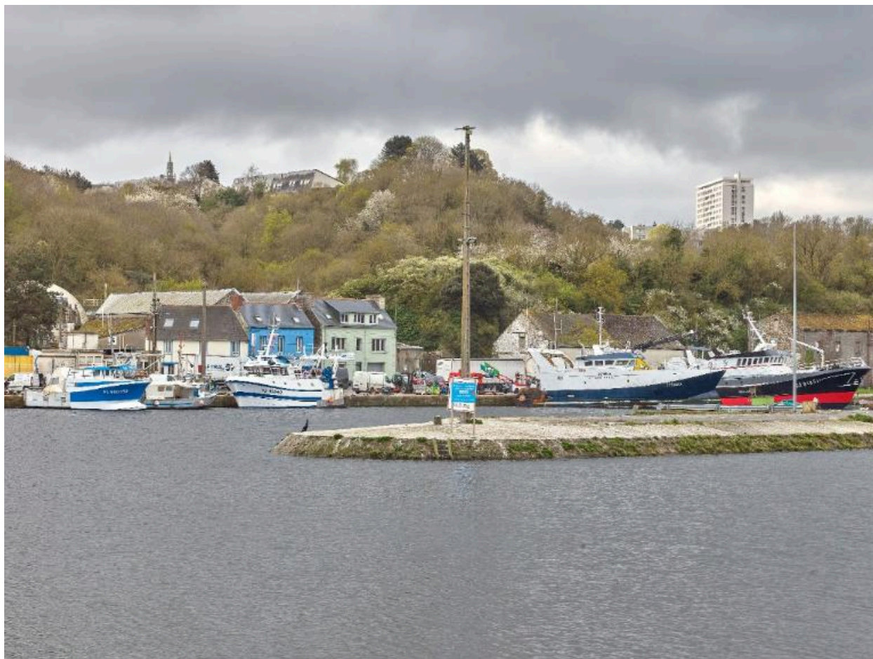
Vue bassin de Mézaubran et de l'accès entre les deux anciens bassins
