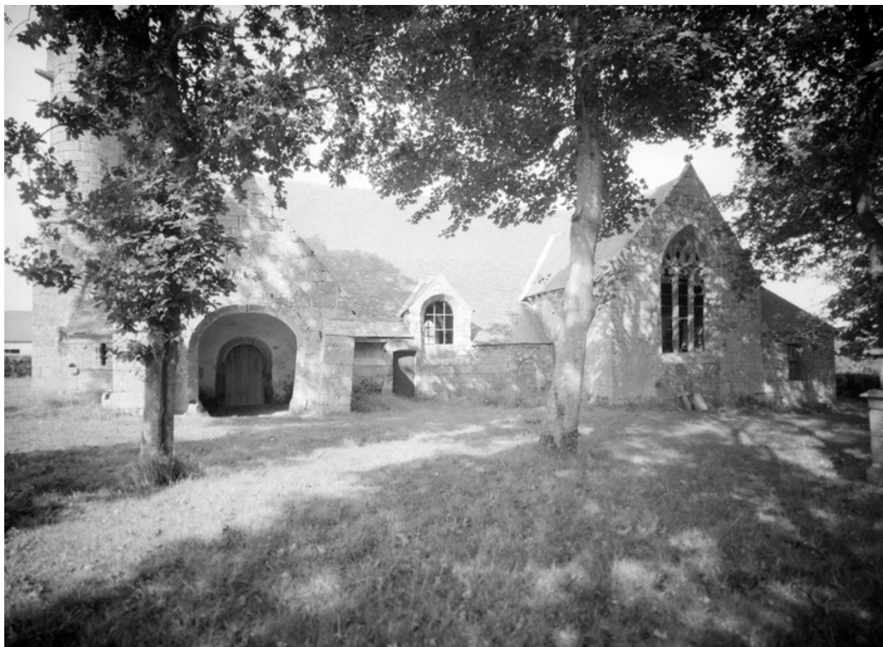
Face sud : vue générale
