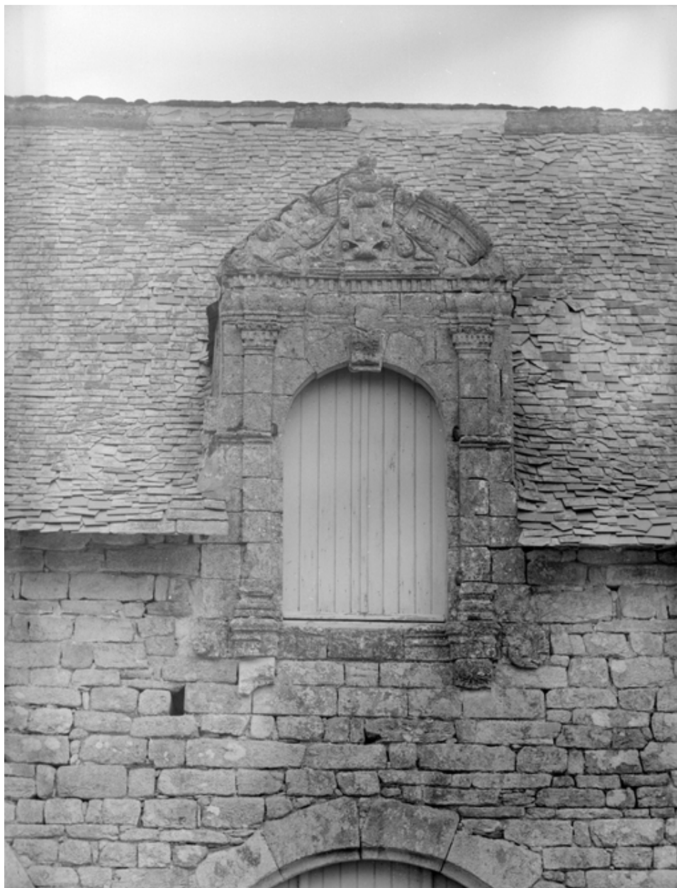
Aile nord, élévation sud : vue générale d'une lucarne
