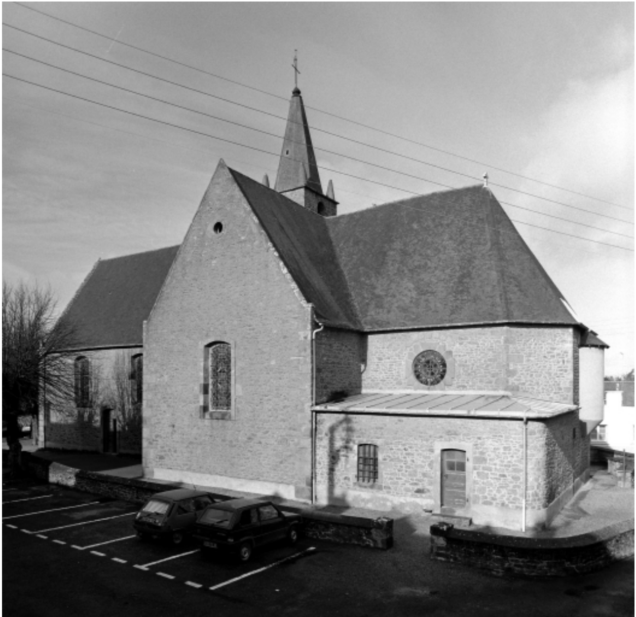
Elévation Sud : vue générale
