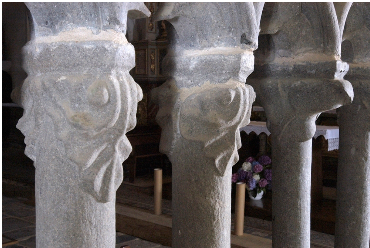
Vue de détail de la séparation ajourée du chœur
