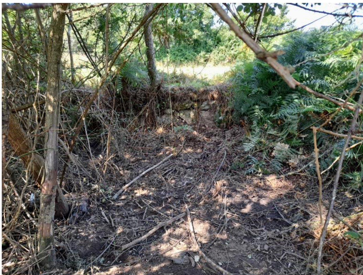
Mur 2, parement est.
