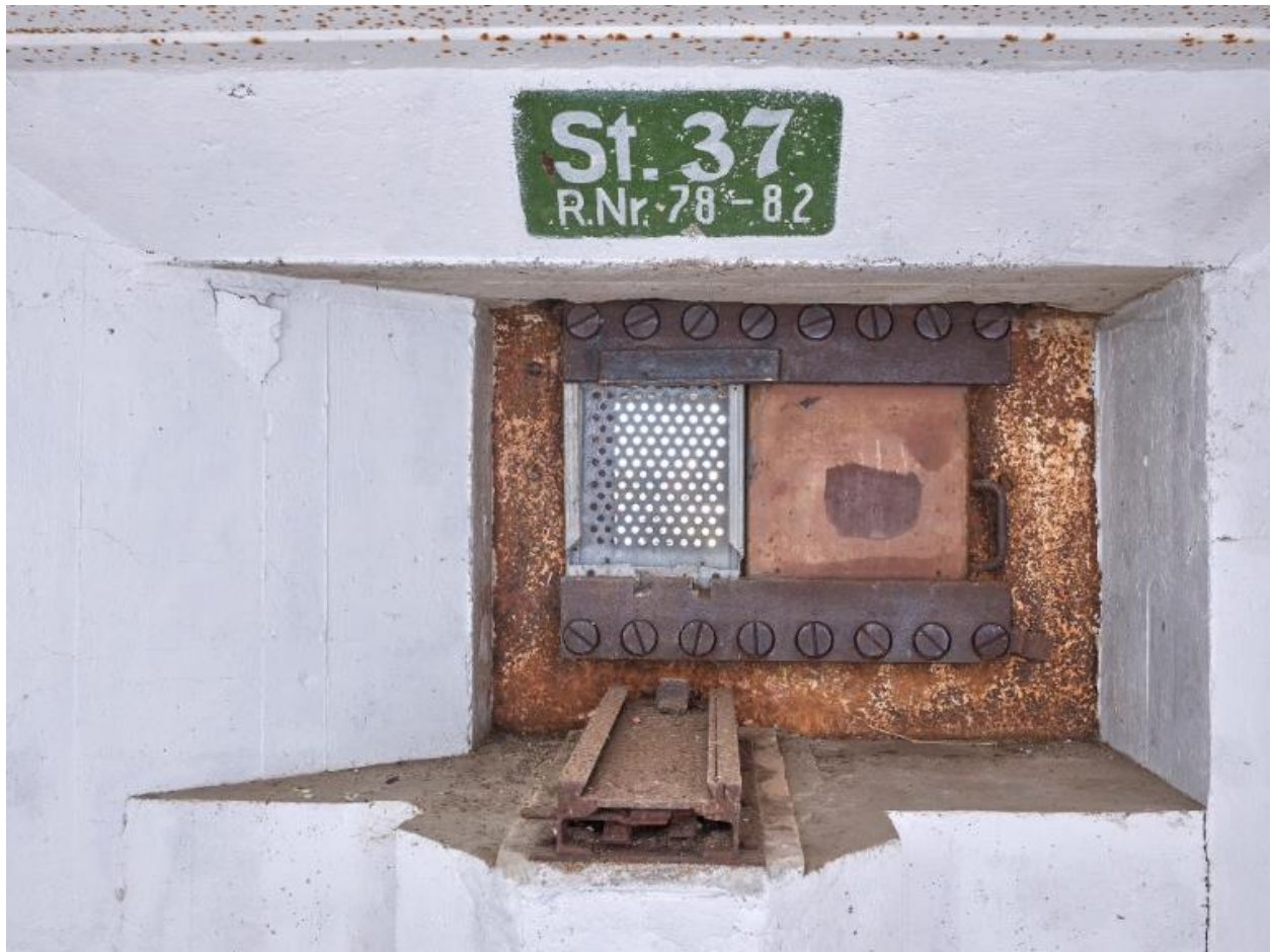
Vue de la chambre de combat : support d'affût de la mitrailleuse et créneau blindé. Au-dessus du poste de tir, cartouche avec marquage. On peut lire : St. 37 ; R.Nr. 78-82
