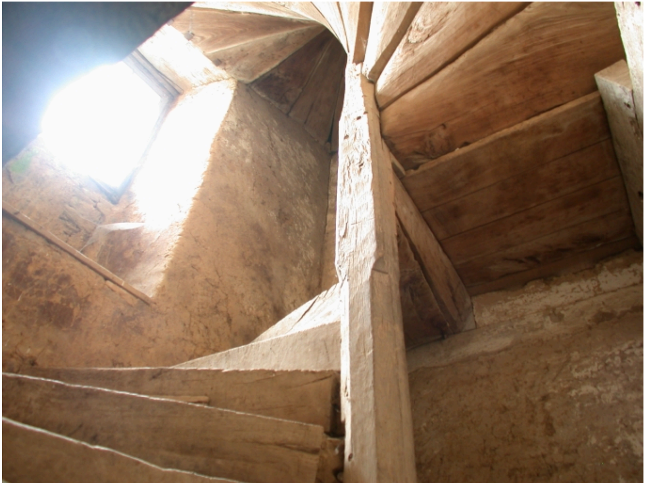
Pavillon nord ouest, détail de l'escalier en bois dans œuvre
