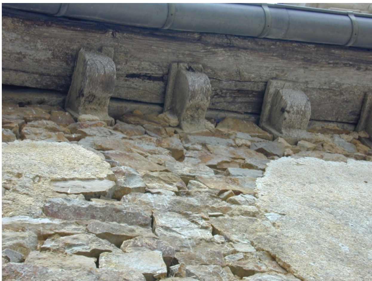
Détail des corbelets de l'orangerie
