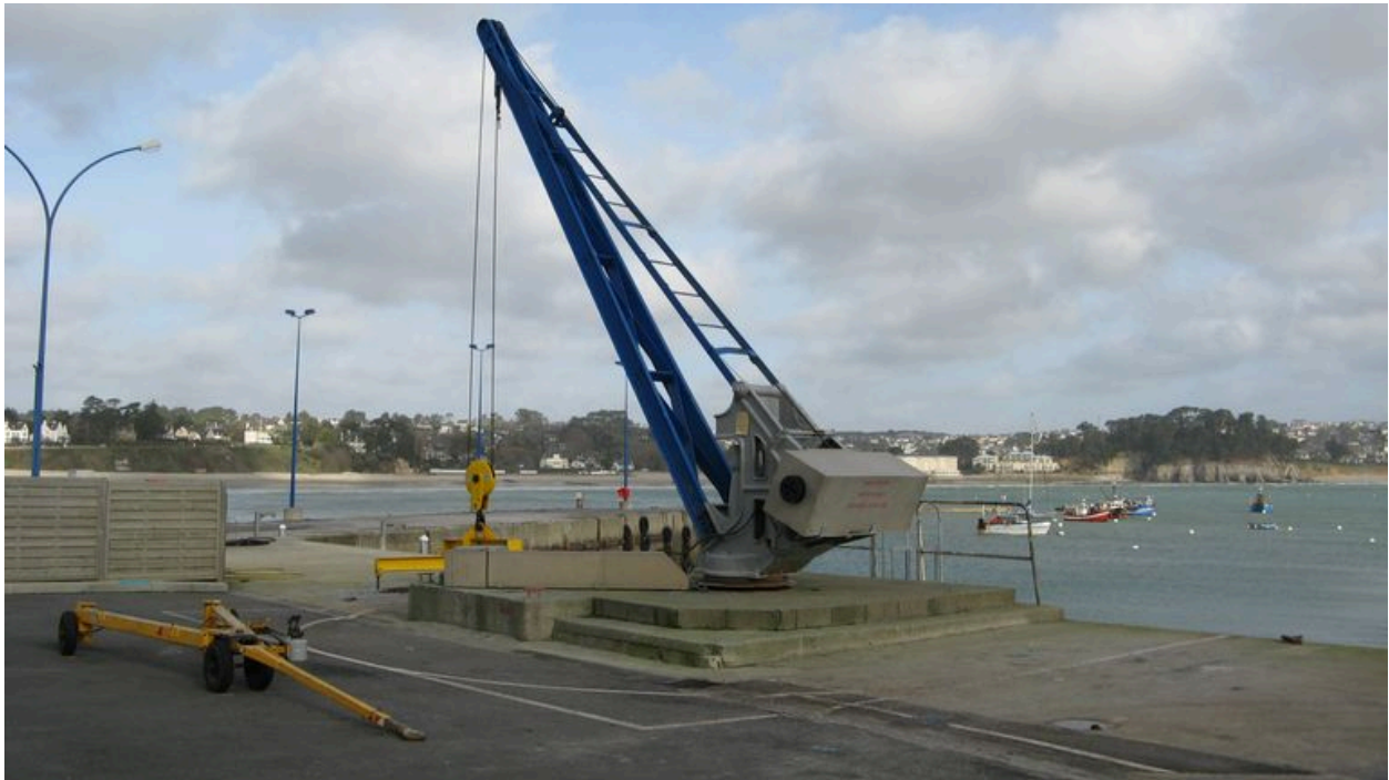
Grue du Kador
