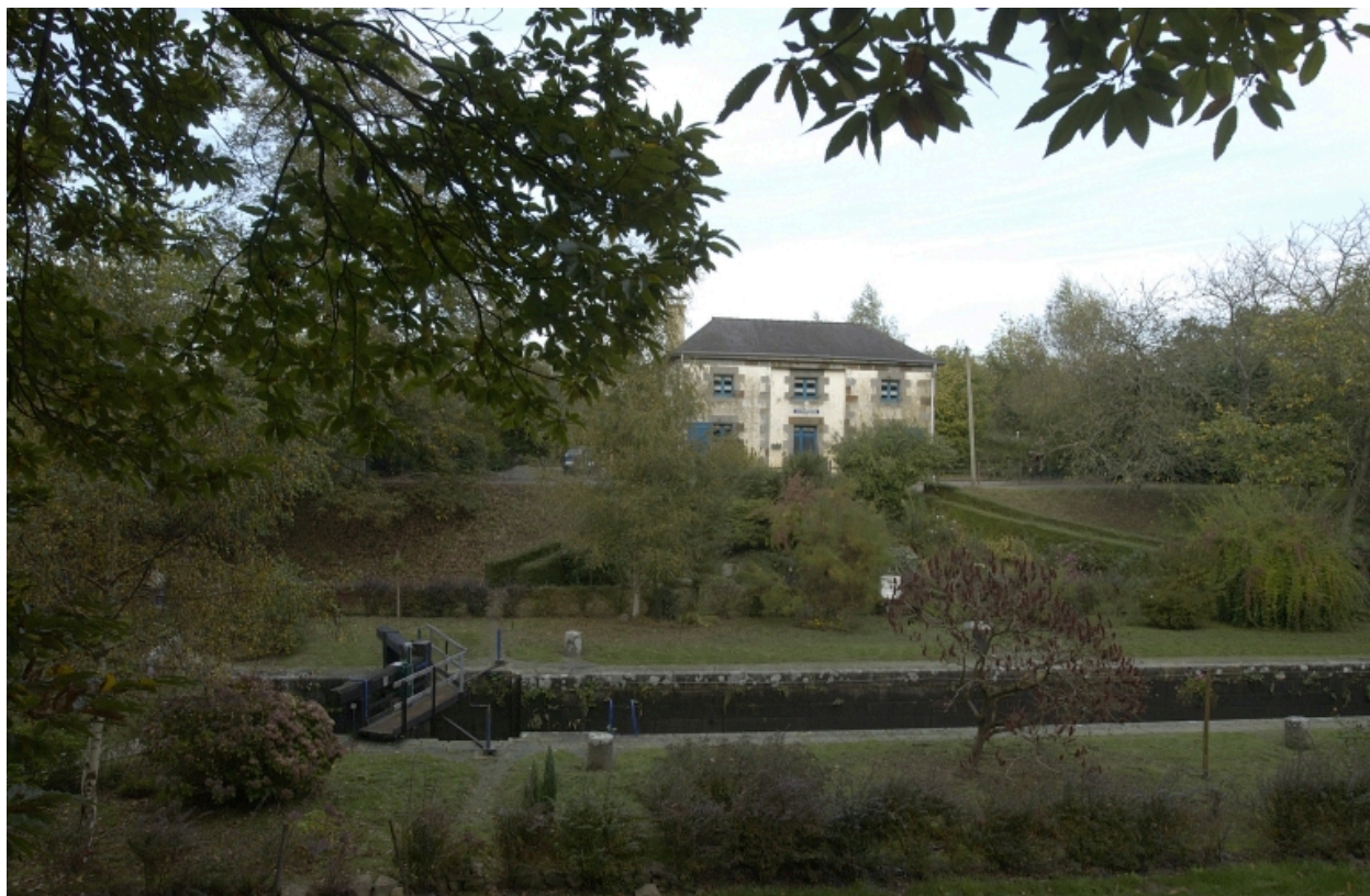
Une des maisons éclusières
