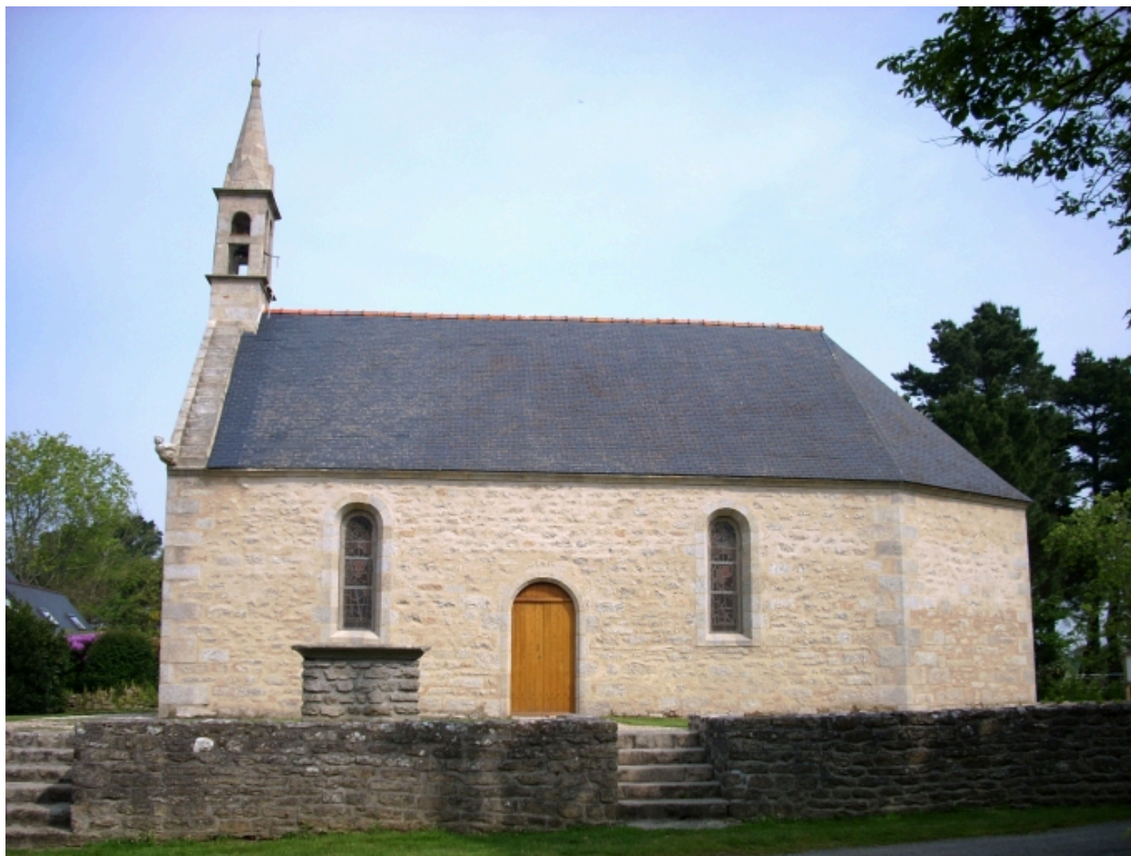
Plomeur, chapelle Saint-Côme et Saint-Damien : élévation sud
