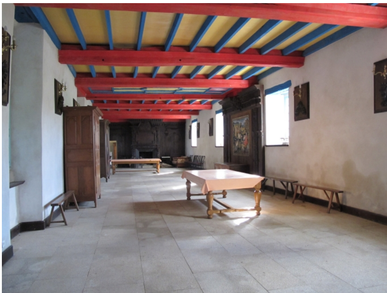
Vue d'ensemble du rez-de-chaussée du bâtiment sud-ouest
