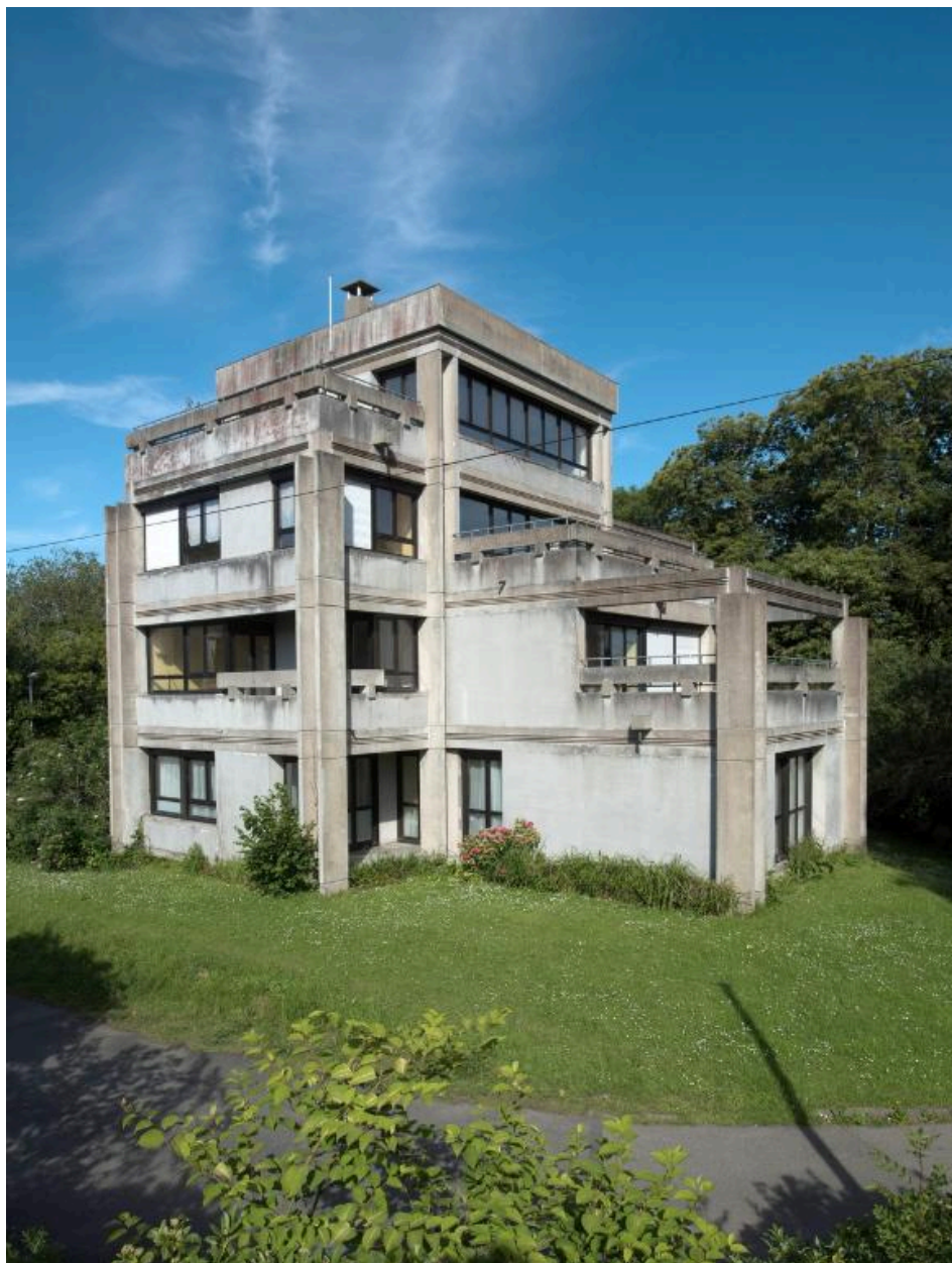
Logements de fonction, angle nord-ouest.
