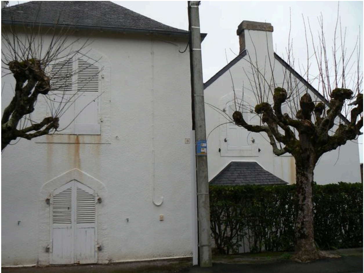
Vue arrière de la villa Ker Skrill, côté terre
