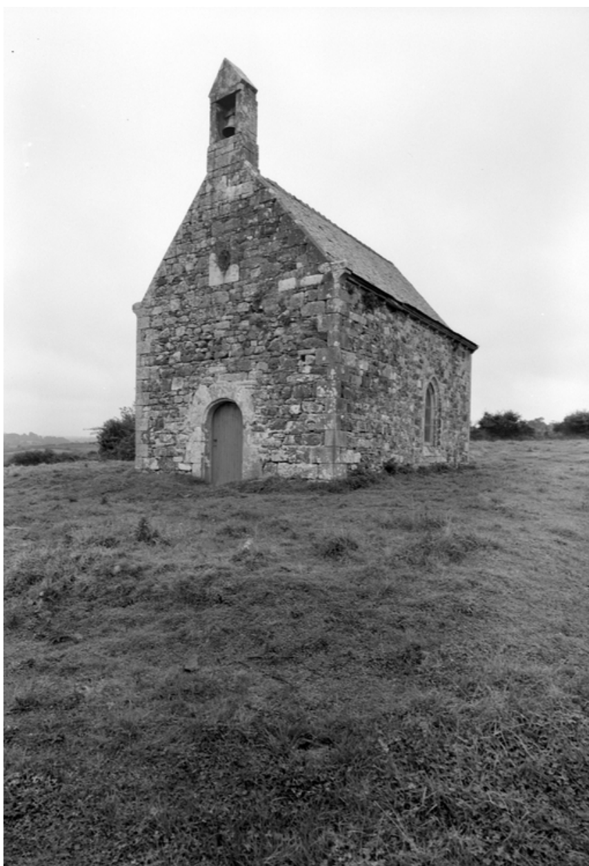
Vue générale des faces ouest et sud
