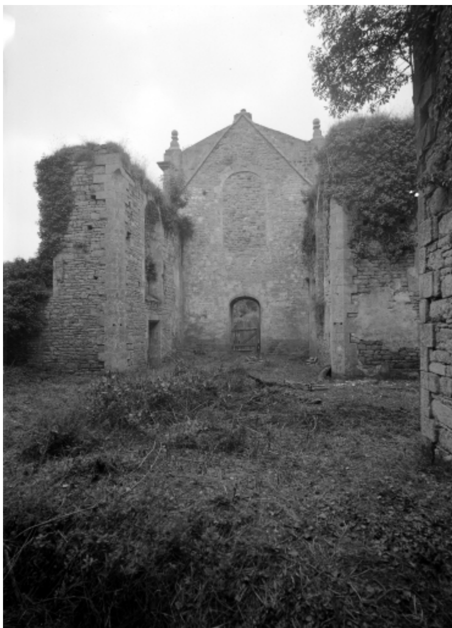
Chapelle, vue intérieure prise vers l'ouest
