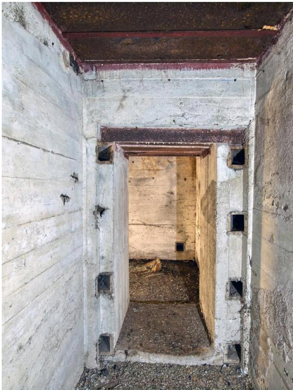
Vue intérieure : emplacement de la porte blindée du magasin de munitions ouest. La porte blindée n'a pas été posée : huit points permettaient de fixer l'hubriserie de la porte
