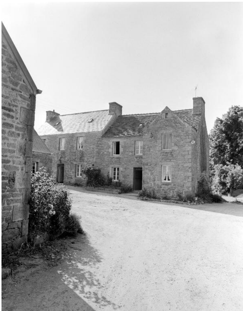
Ferme, élévation sud, vue générale
