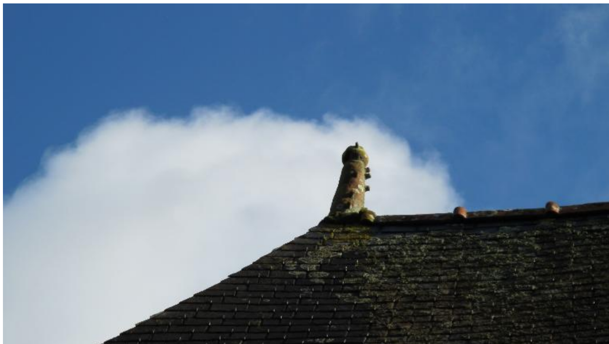
Communs au sud du logis, épi de faitage, état en 2015
