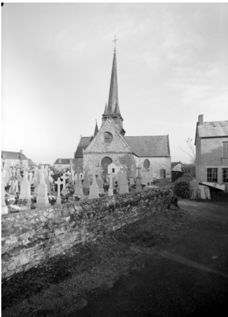
Elévation ouest : vue de situation
