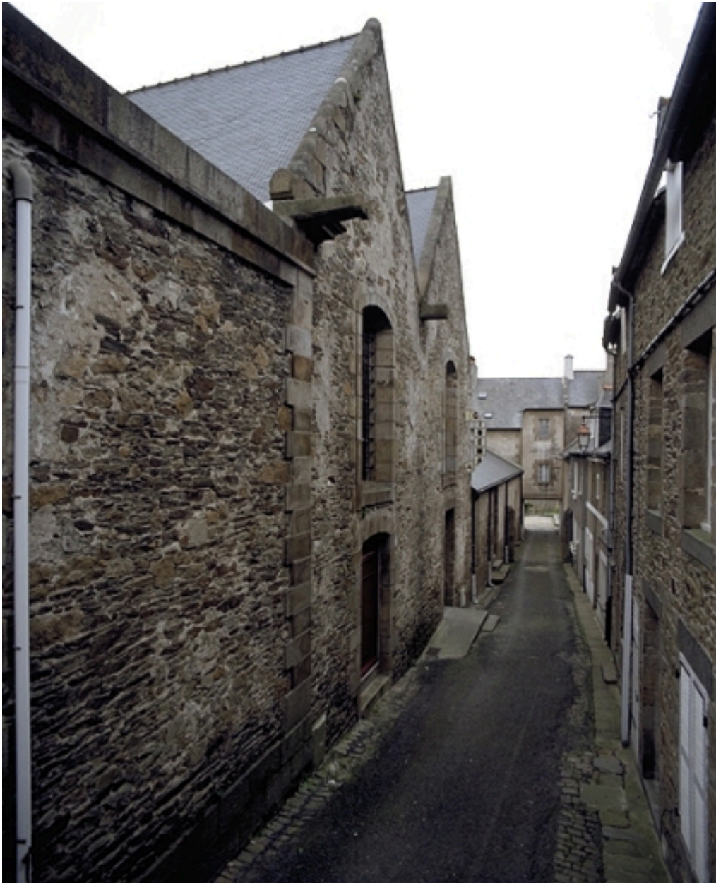
Vue latérale sud depuis l'impasse Saint-Méen
