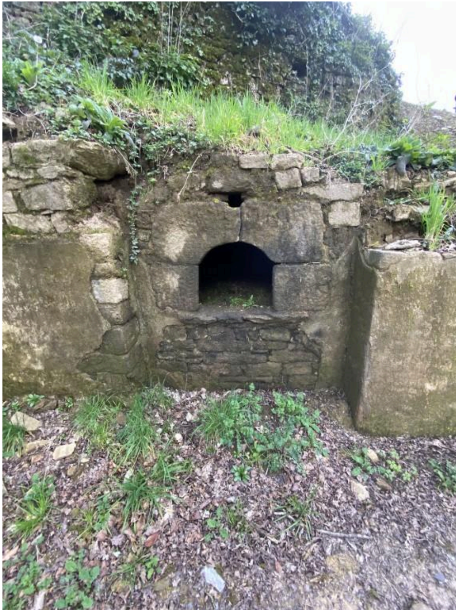
Four à pain, ruine, vue nord
