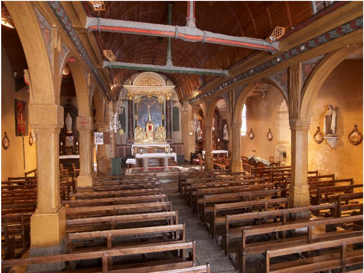
Intérieur : vue générale vers le chœur
