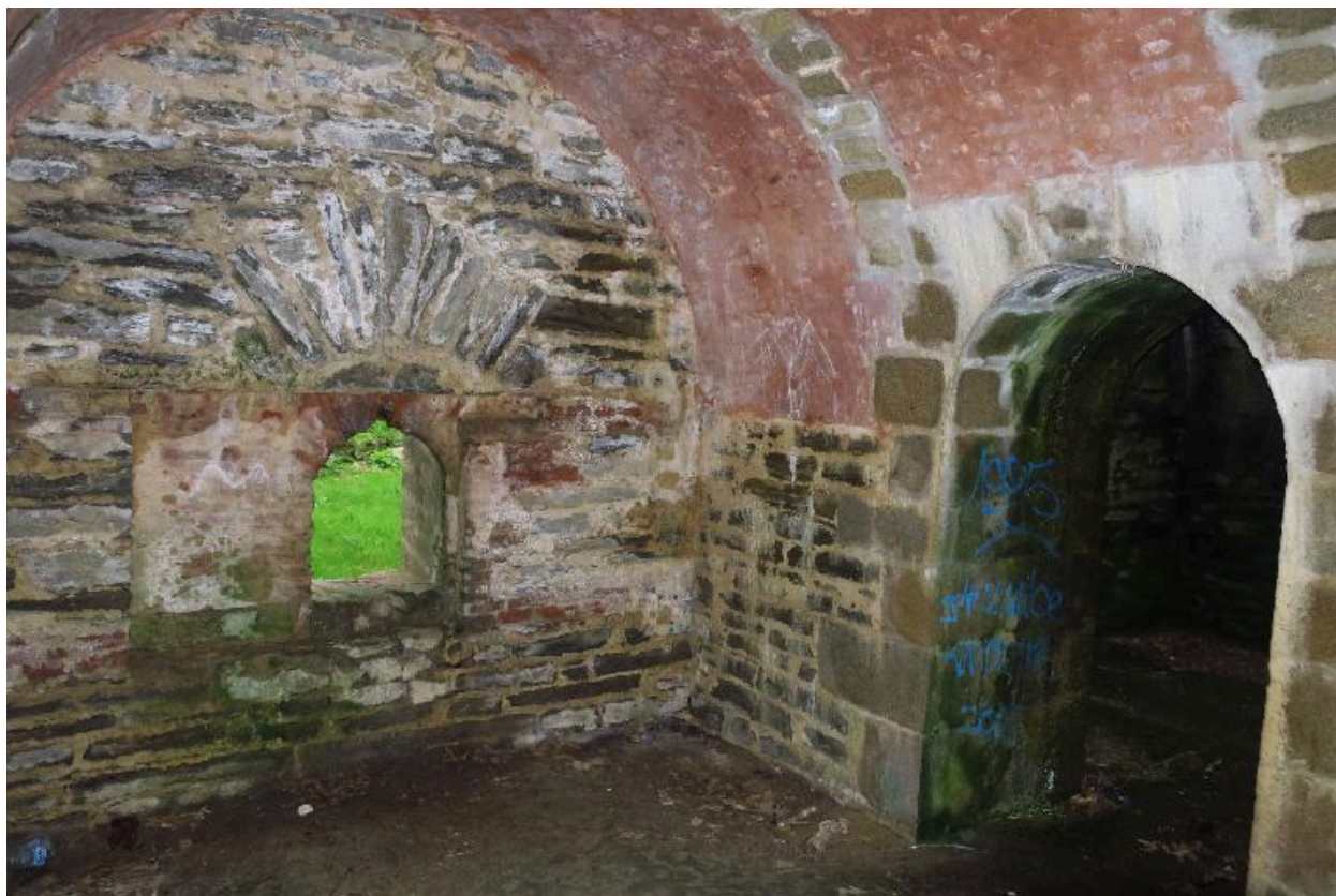
Le Palais, enceinte urbaine, réduit H, casemate d'artillerie.
