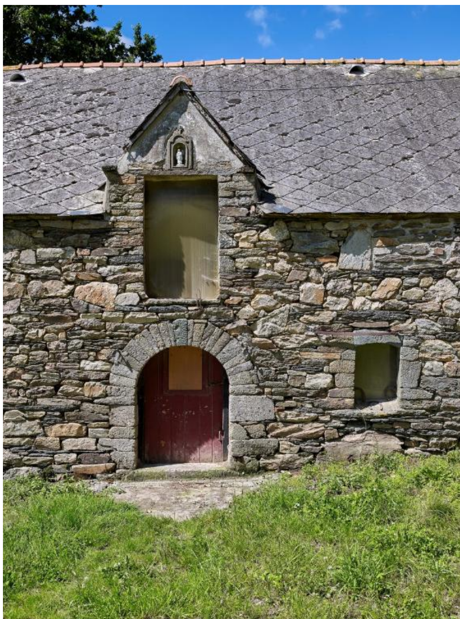
Logis-étable 1753. Elévation sud-est. Détail de la porte, de la fenêtre de la salle et de la fenêtre de lucarne
