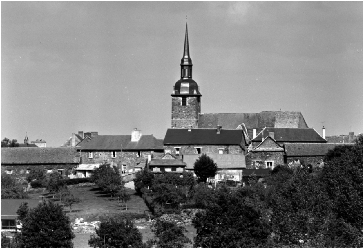
Elévation Sud : vue de situation
