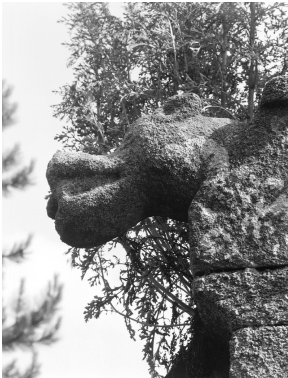
Bras nord du transept, détail : pierre d'assise est du rampant
