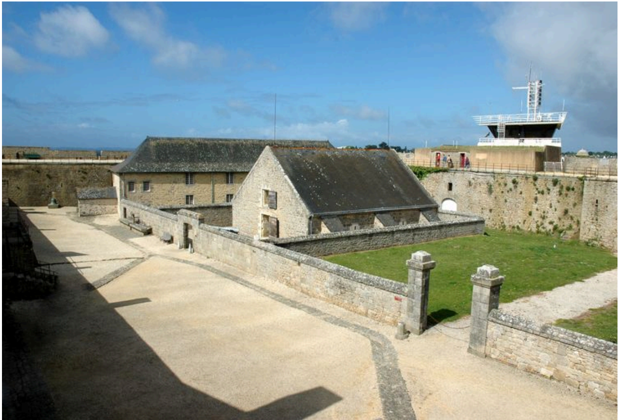
Vue de la citadelle de Port-Louis : parc à boulets, magasin à poudre et arsenal. Sémaphore installé sur le grand bastion
