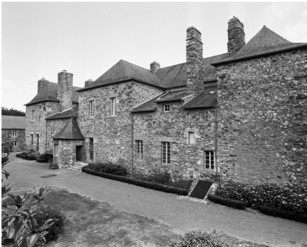
Logis, élévation ouest
