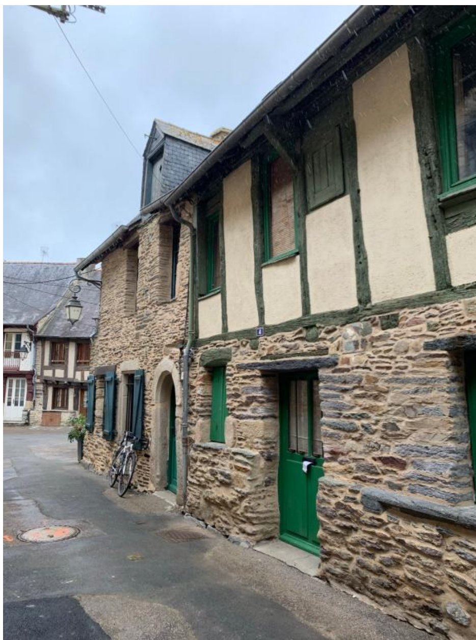
Elévation est, vue depuis le nord
