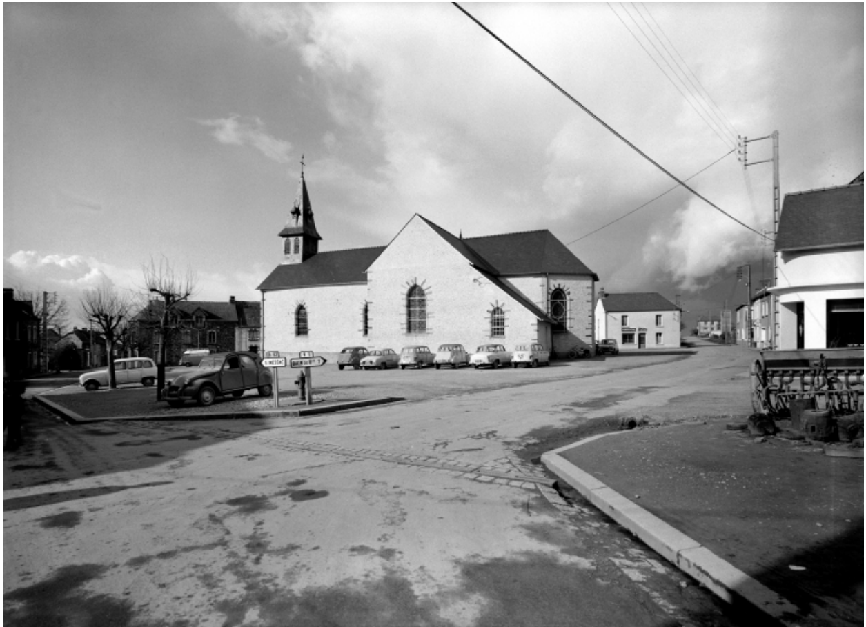
Elévation Sud-Est : vue générale
