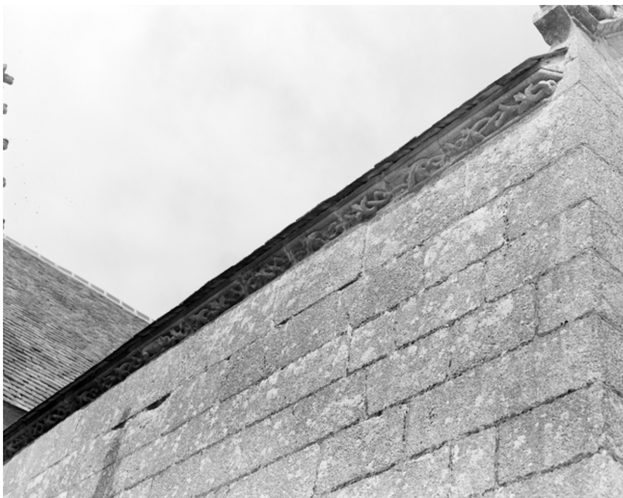
Transept, bras sud : corniche du mur ouest
