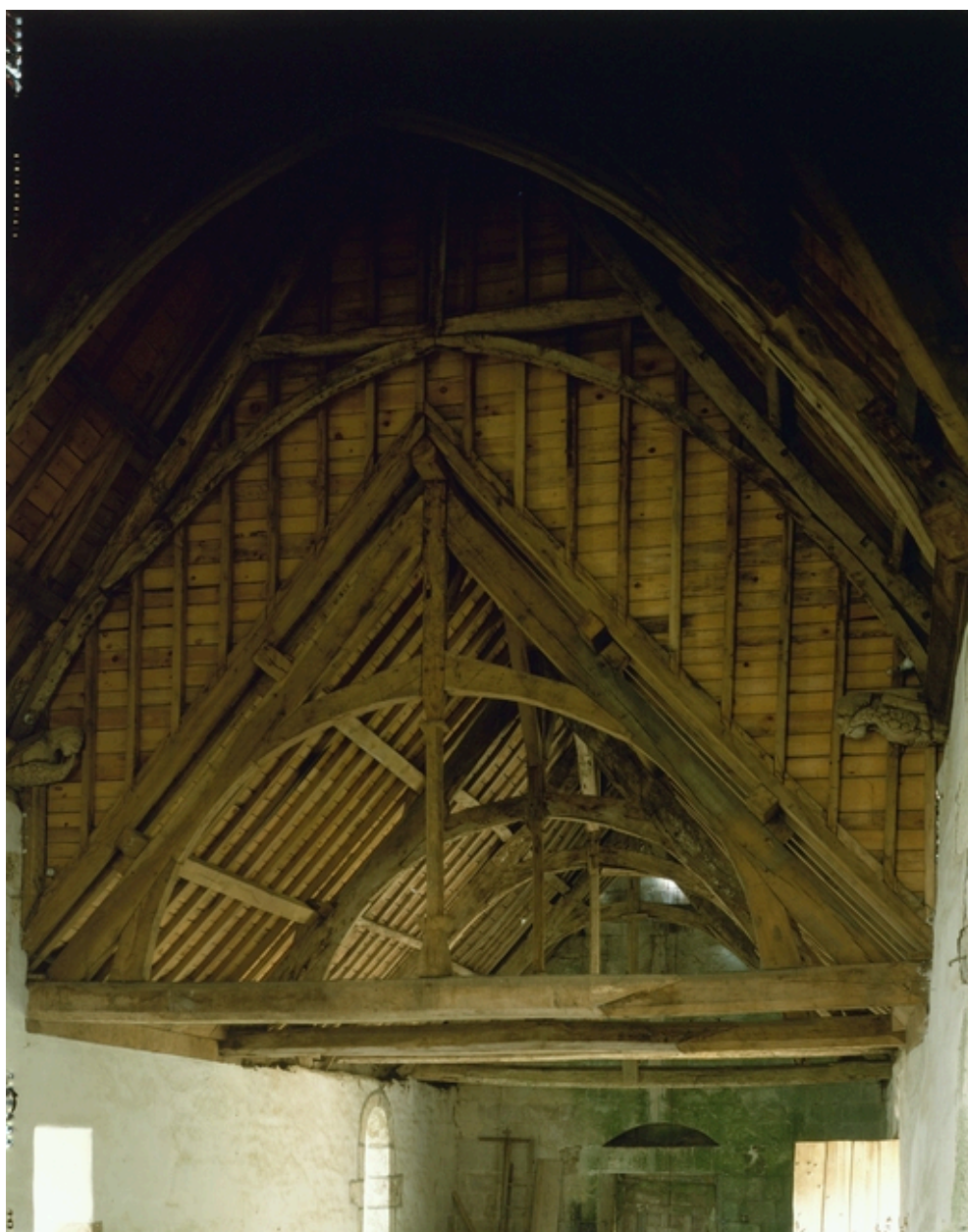
Charpente : vue vers l'ouest
