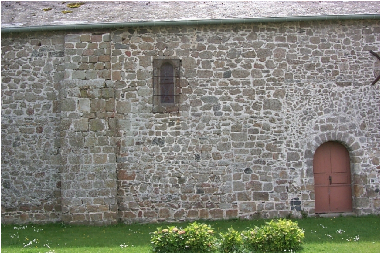
Mur nord : vestiges des parties romanes
