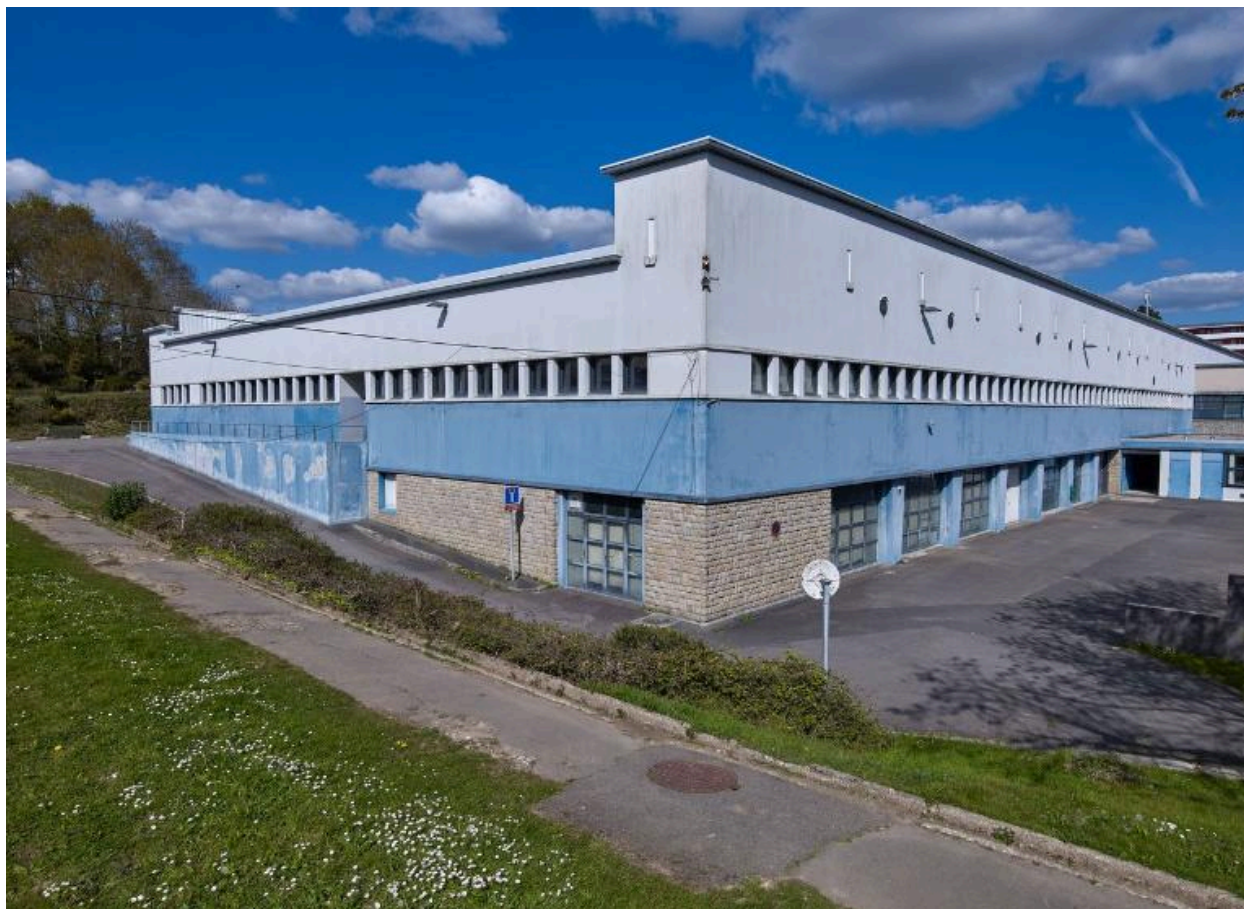
Les ateliers, vue de l'angle sud-ouest. J-B. Mathon, architecte.
