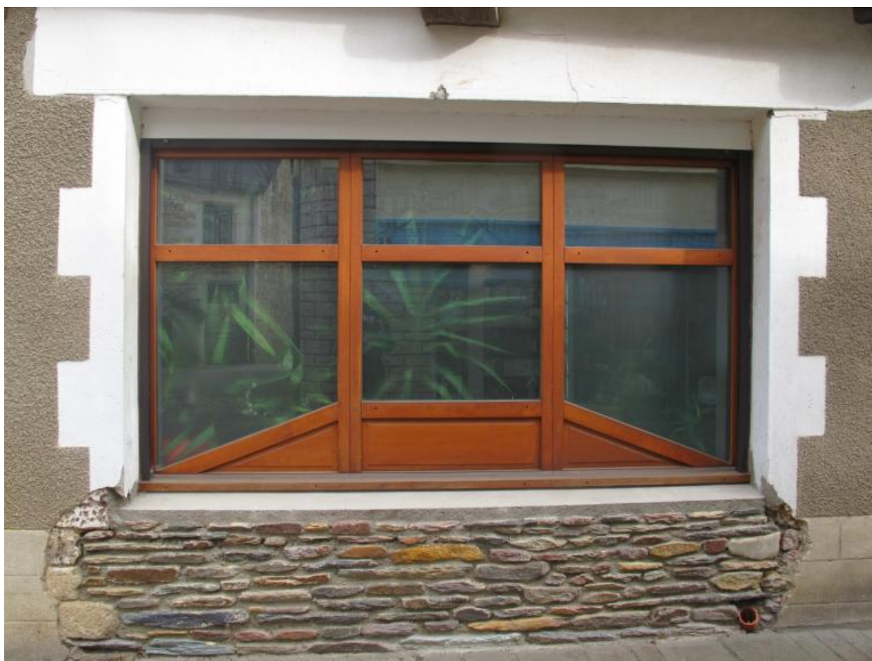
Façade nord. Rez-de-chaussée, partie ouest, fenêtre
