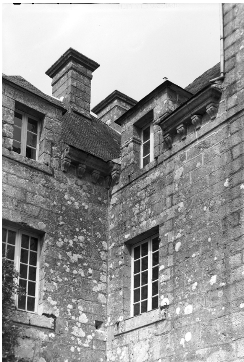
Détail de la corniche de la face ouest et de l'aile nord, et lucarnes passantes
