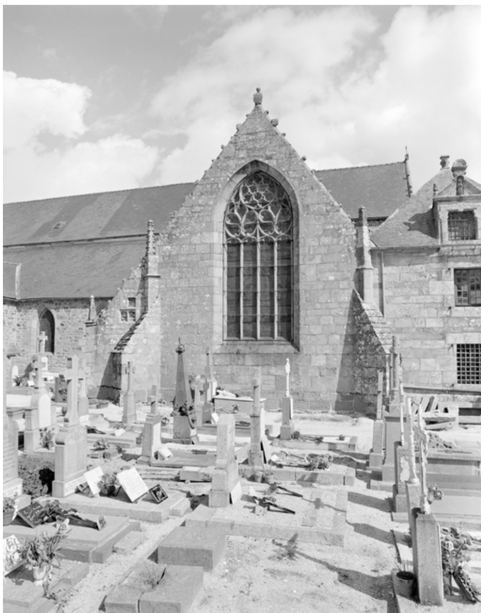
Bras sud : fenêtre
