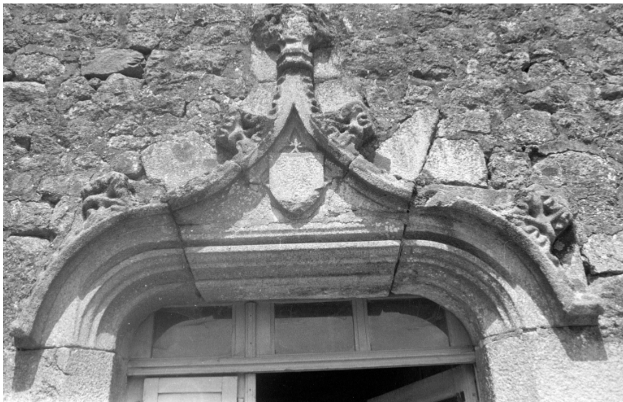
Linteau de la porte
