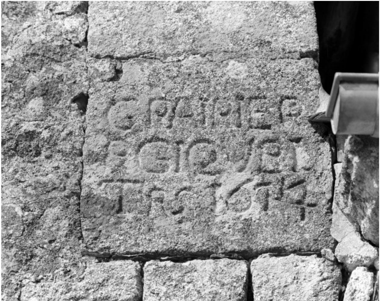
Elévation sud, tour ouest : détail de l'inscription
