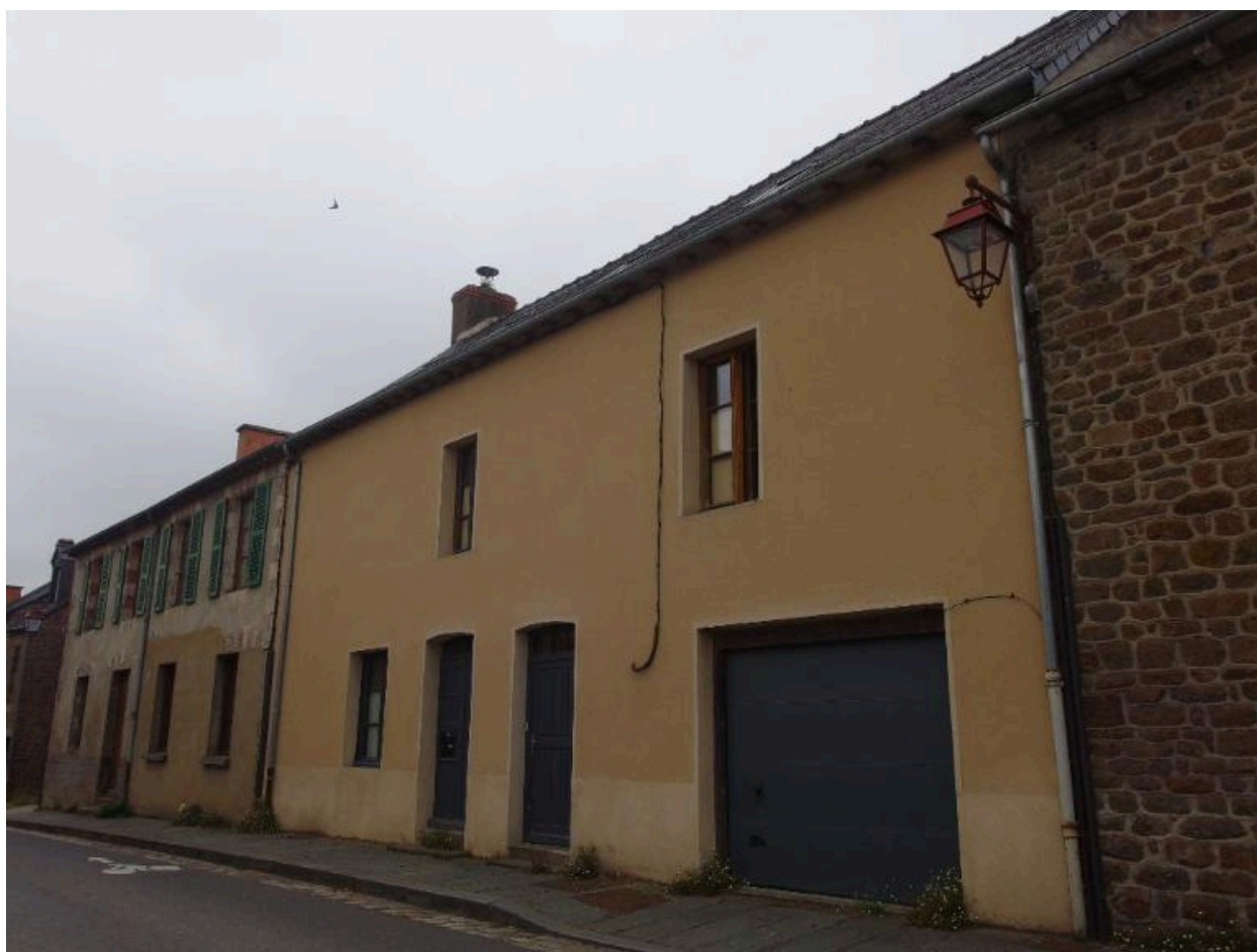
Vue de la façade est
